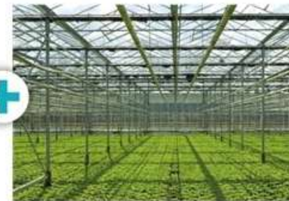
CHAUFFAGE DE SERRES
